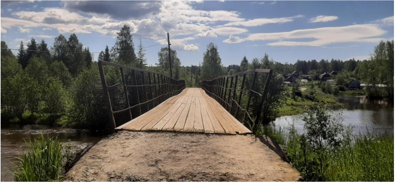
Рисунок 1- Вид на существующий подвесной мост
