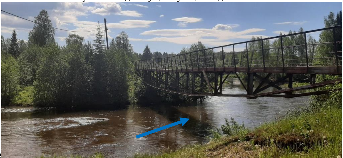
Рисунок 2- Вид на существующий подвесной мост
