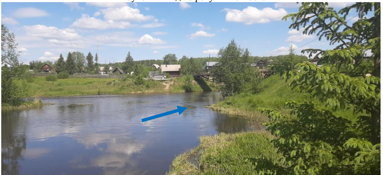
Рисунок 5- Вид на реку выше моста
