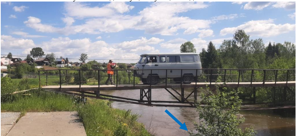
Рисунок 3- Вид на существующий подвесной мост
