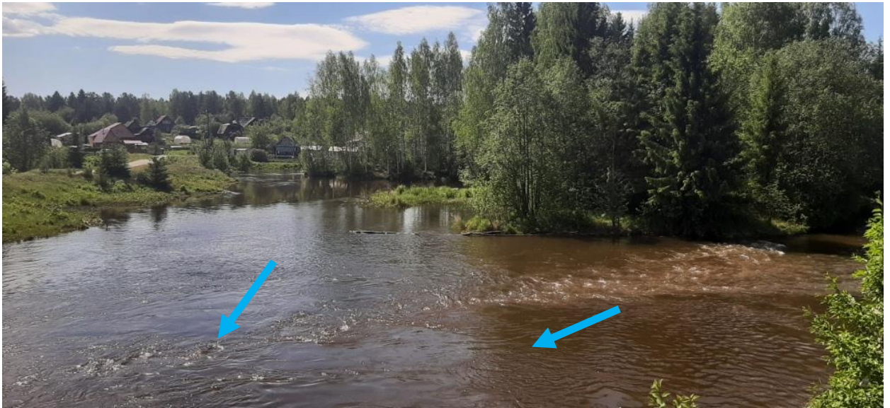
Рисунок 4- Вид на реку выше моста
