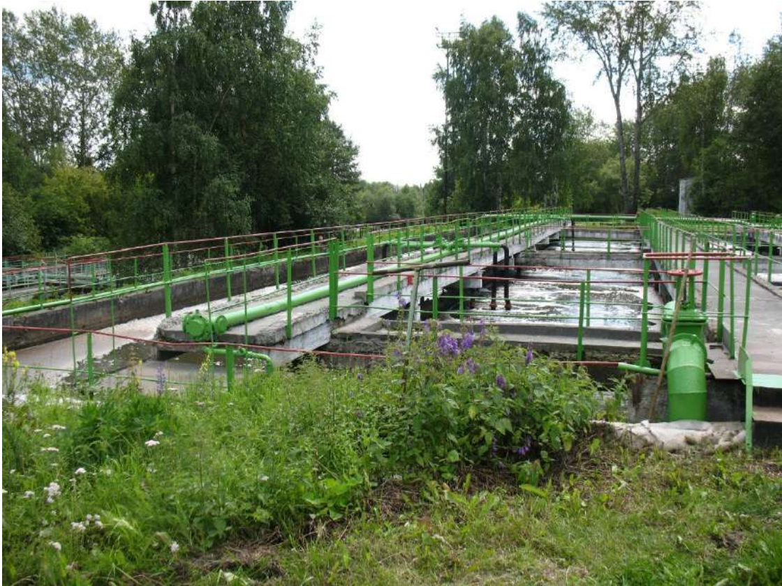
Рисунок 11. Аэротенк 2-й очереди (КОС г. Качканар).
