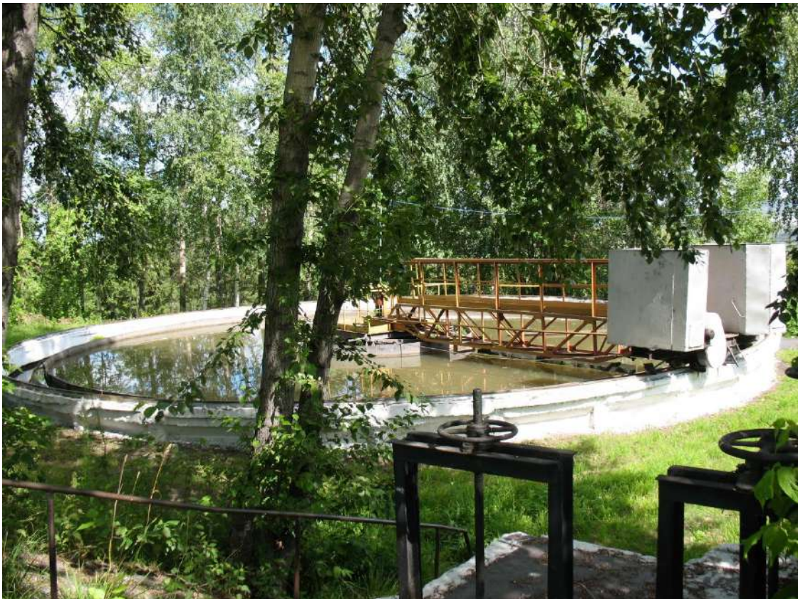
Рисунок 9. Первичный радиальный отстойник 2-й очереди (КОС г. Качканар).
