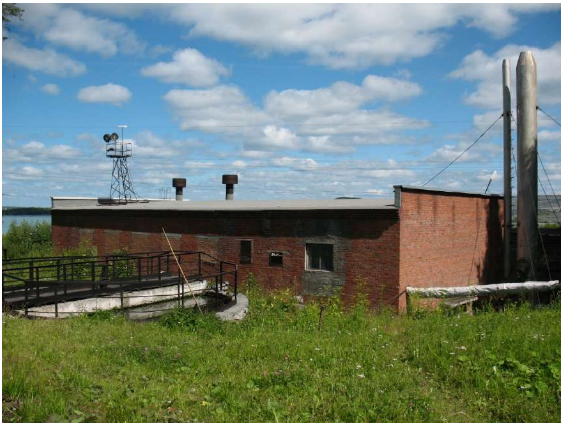
Рисунок 14. Здание хлораторной (КОС г. Качканар).
