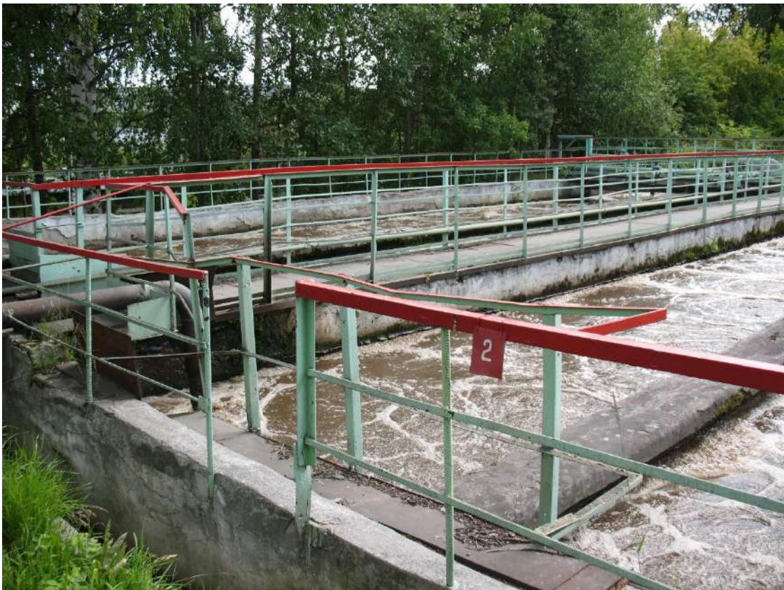
Рисунок 12. Аэротенк 1-й очереди (КОС г. Качканар).
