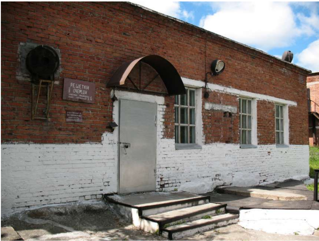
Рисунок 7. Здание решеток 2-й очереди (КОС г. Качканар).
