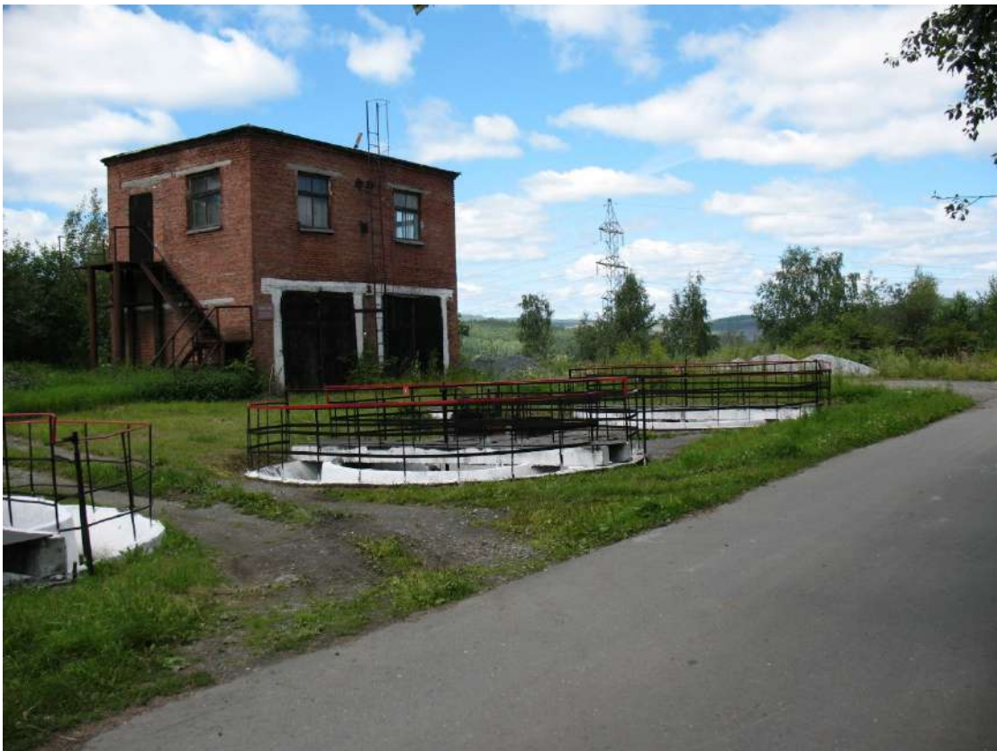
Рисунок 8. Песколовки второй очереди строительства (КОС г. Качканар).
