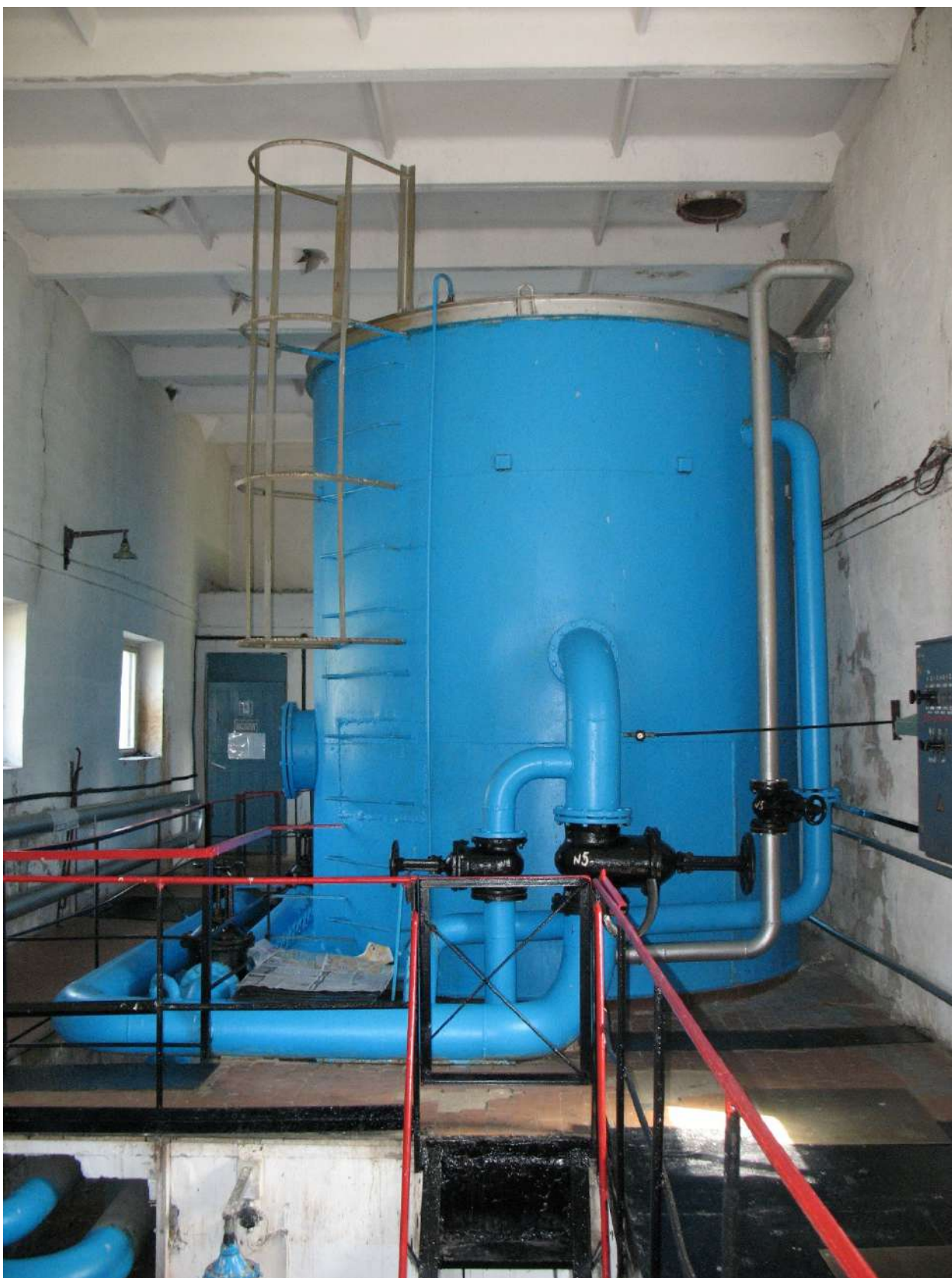
Рисунок 20. Песчаный фильтр блока доочистки (КОС пос. Валериановск).
