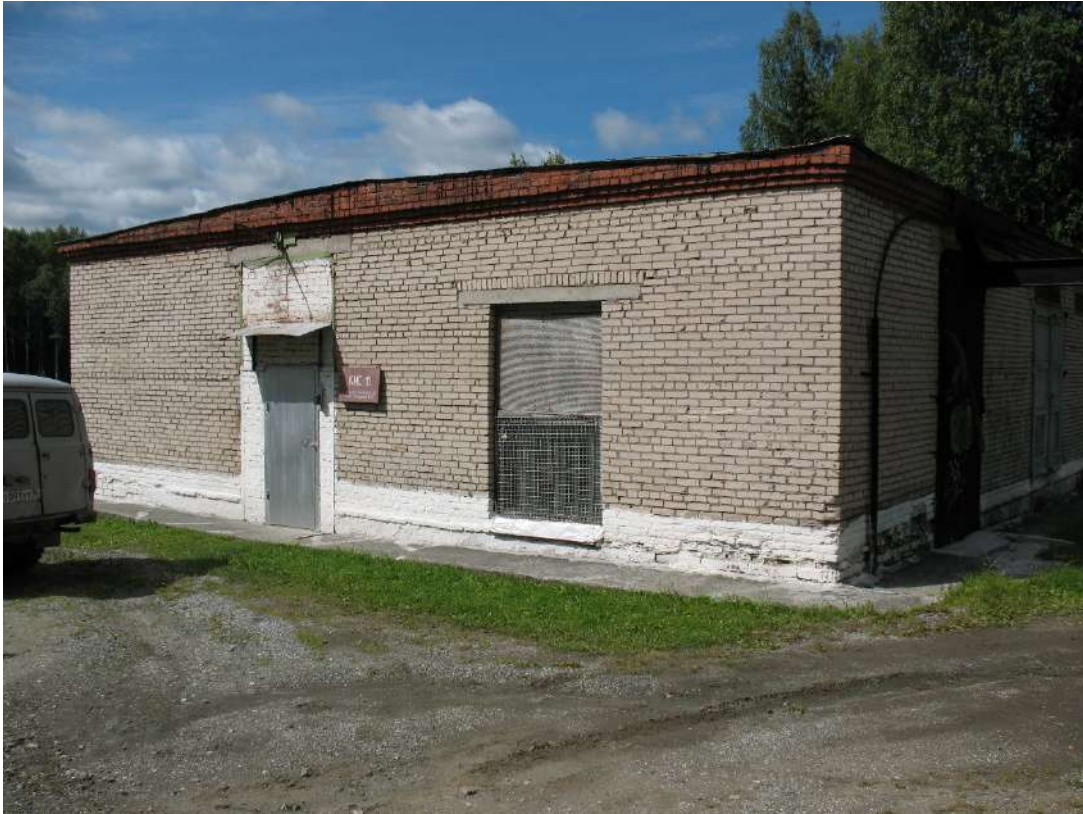
Рисунок 5. Здание КНС №10 (г. Качканар).
