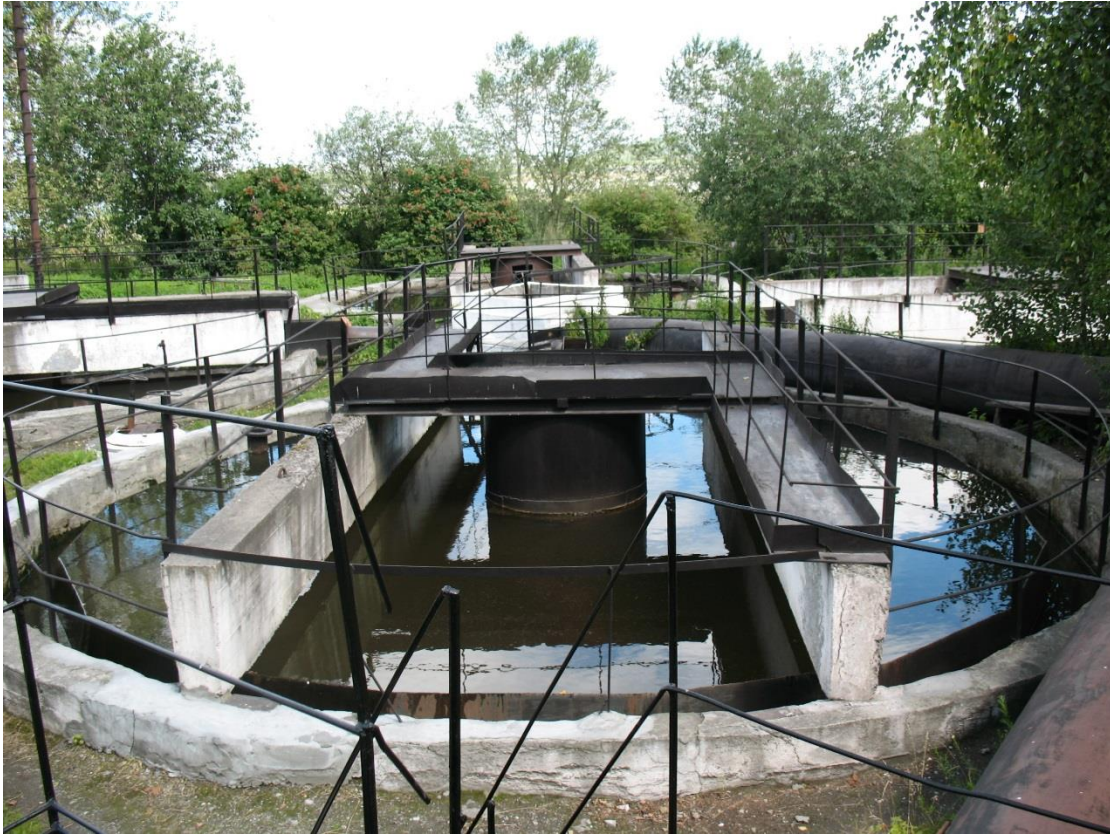
Рисунок 13. Вторичные вертикальные отстойники 2-й очереди (КОС г. Качканар).
