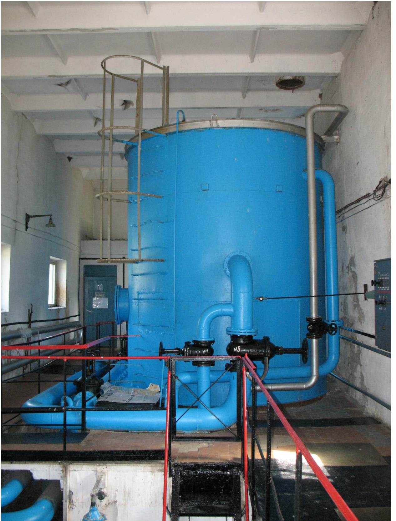
Рисунок 20. Песчаный фильтр блока доочистки (КОС пос. Валериановск).
