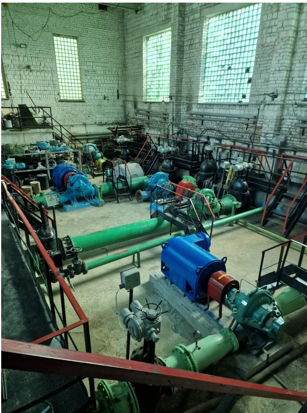
Рисунок 15. Машинный зал НС II верхней зоны системы водоснабжения.
