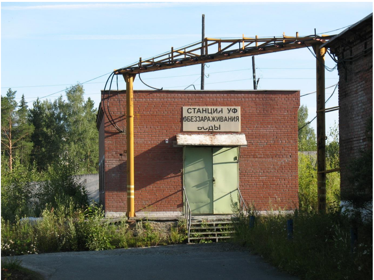
Рисунок 12. Здание станции УФ-обеззараживания.
