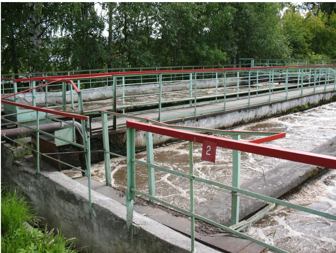
Рисунок 12. Аэротенк 1-й очереди (КОС г. Качканар).
