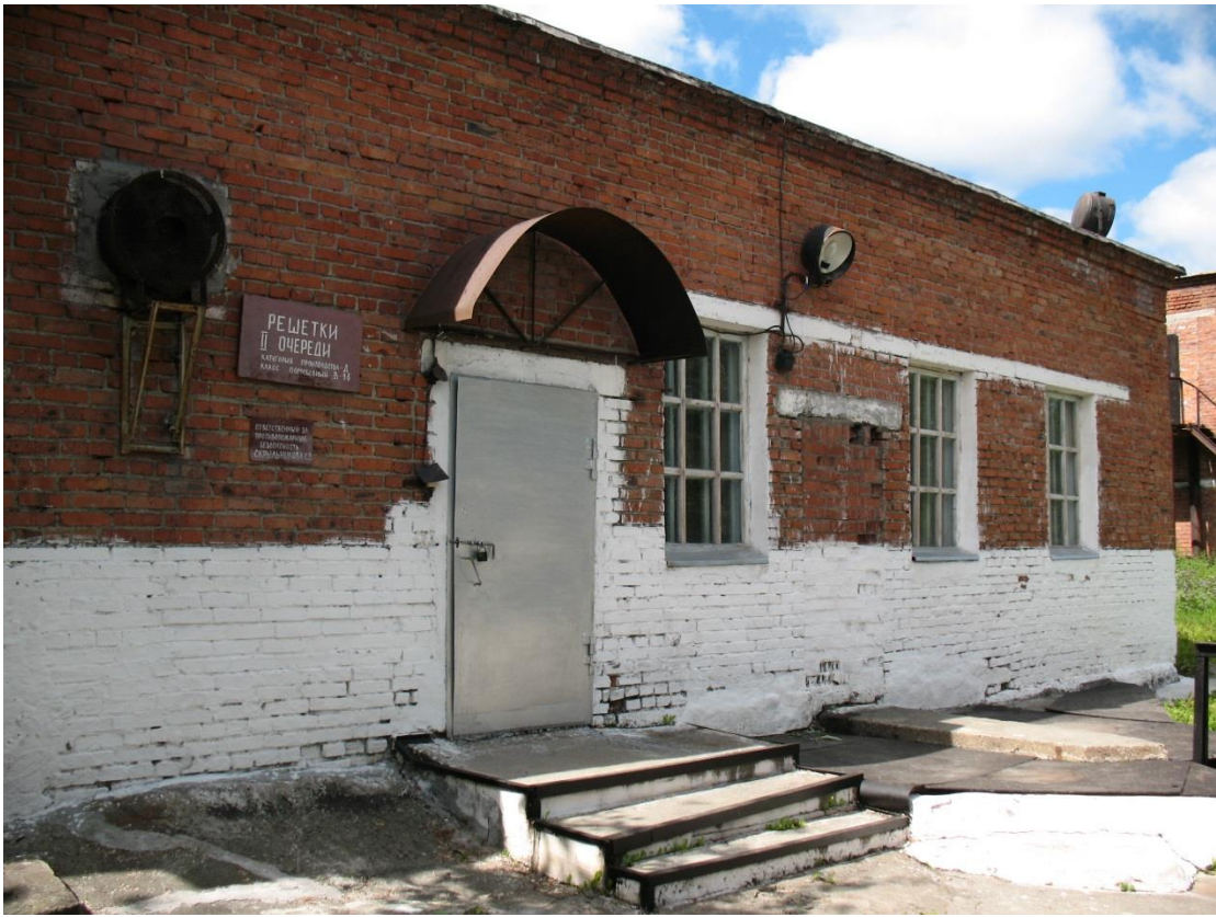
Рисунок 7. Здание решеток 2-й очереди (КОС г. Качканар).
