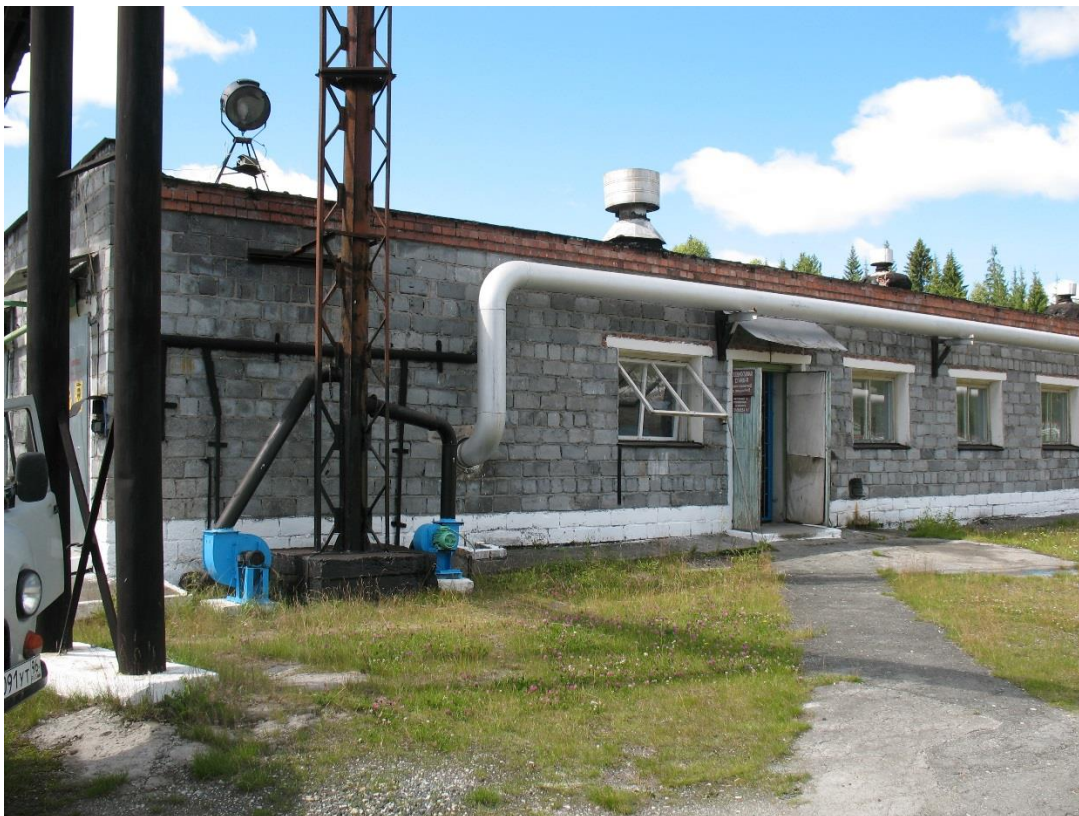
Рисунок 18. Главный корпус КОС с воздуходувной станцией и хлораторной (КОС пос. Валериановск).
