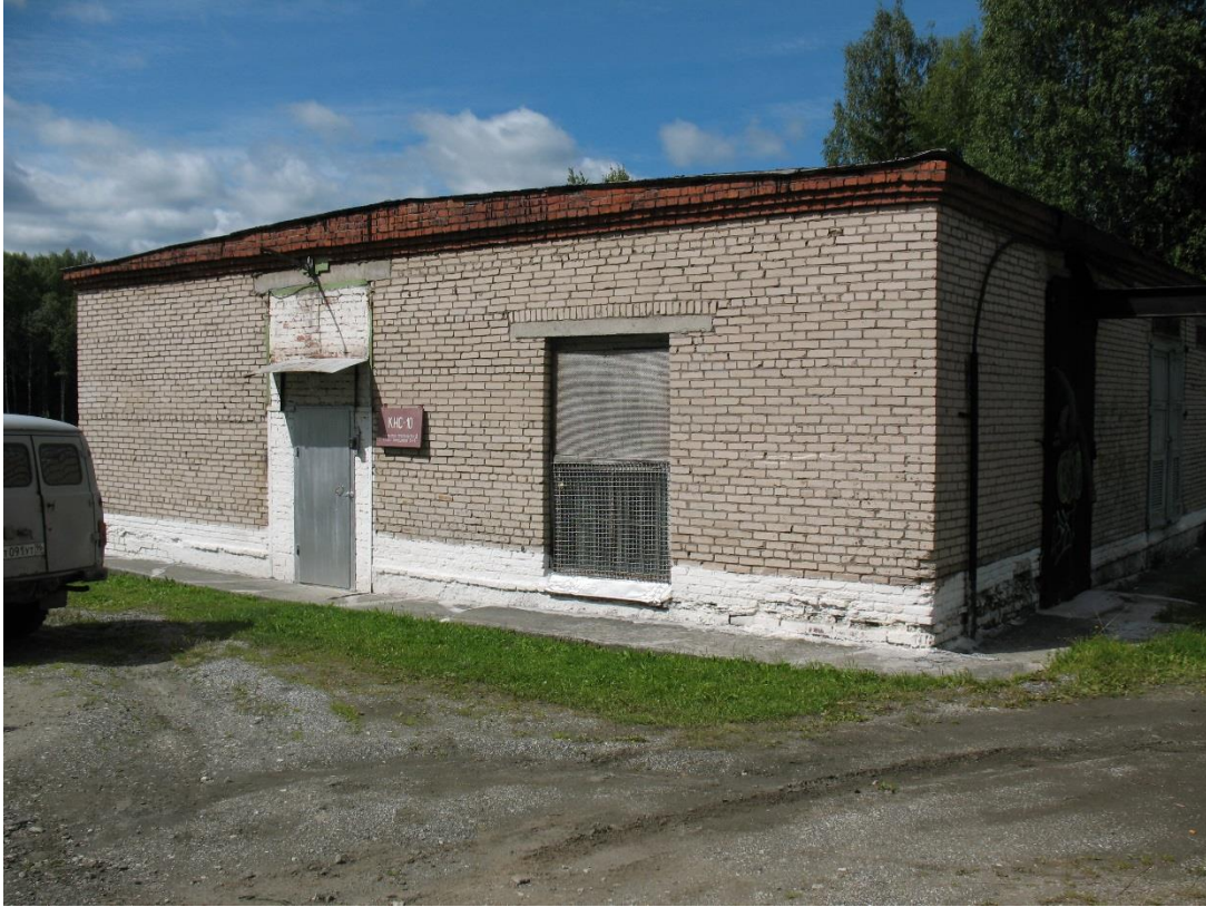
Рисунок 5. Здание КНС №10 (г. Качканар).
