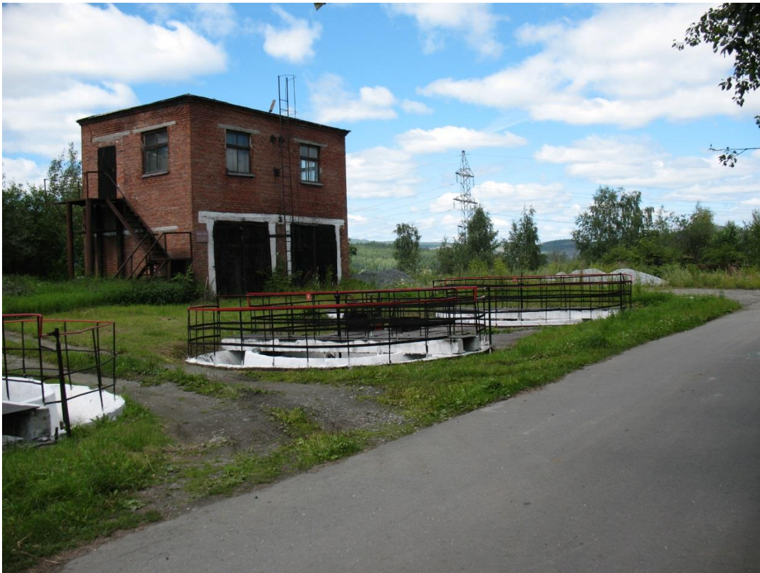
Рисунок 8. Песколовки второй очереди строительства (КОС г. Качканар).
