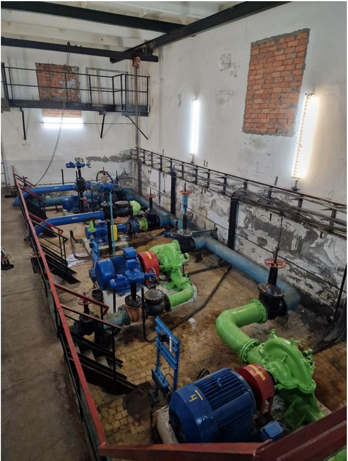
Рисунок 16. Машинный зал НС III верхней технологической зоны водоснабжения.
