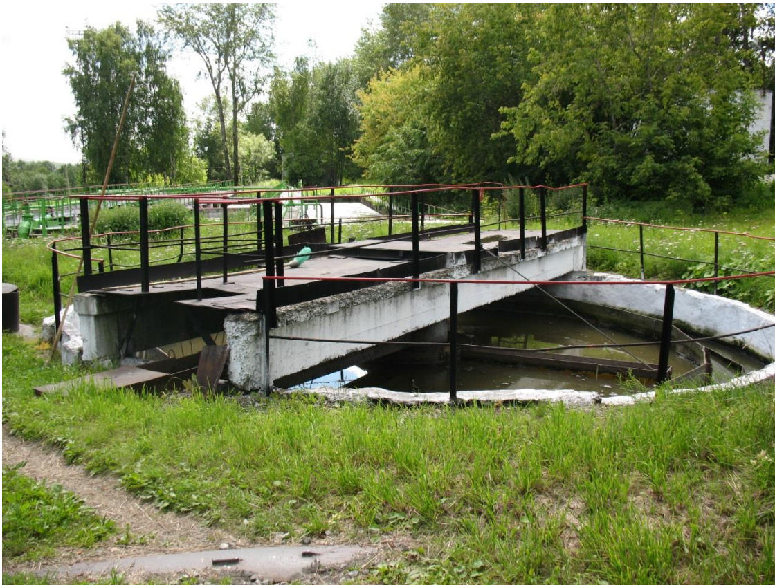
Рисунок 10. Первичный вертикальный отстойник 2-й очереди (КОС г. Качканар).
