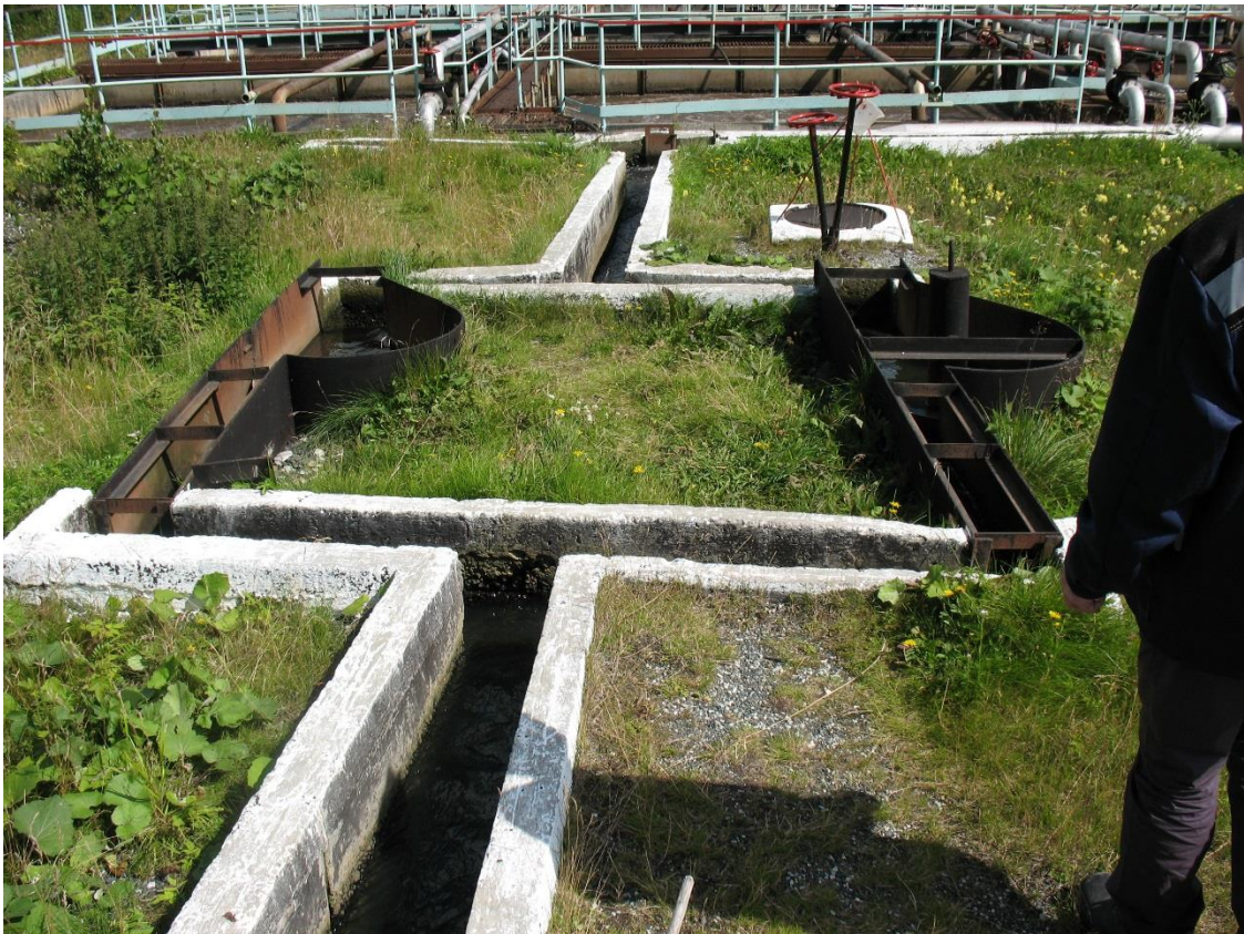
Рисунок 17. Песколовки (КОС пос. Валериановск).
