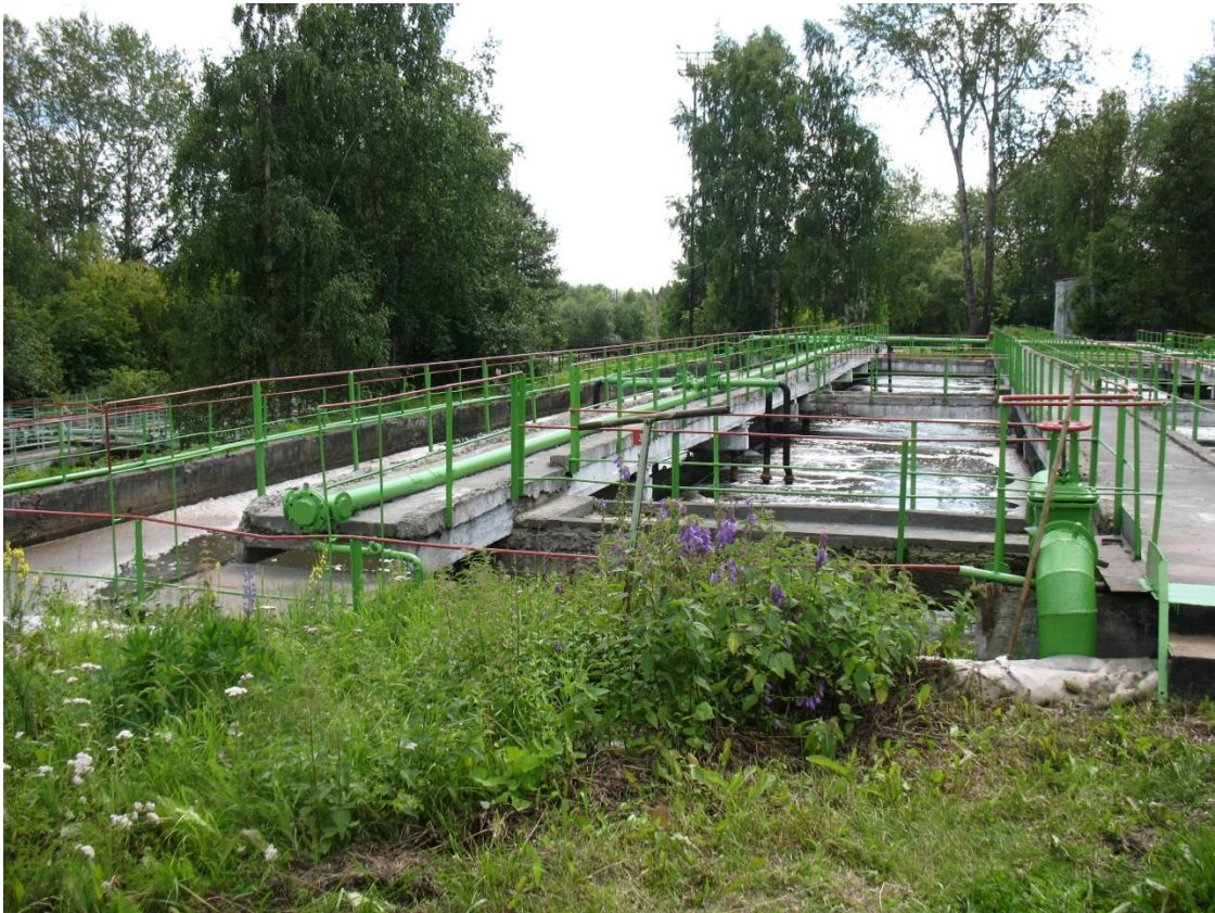
Рисунок 11. Аэротенк 2-й очереди (КОС г. Качканар).
